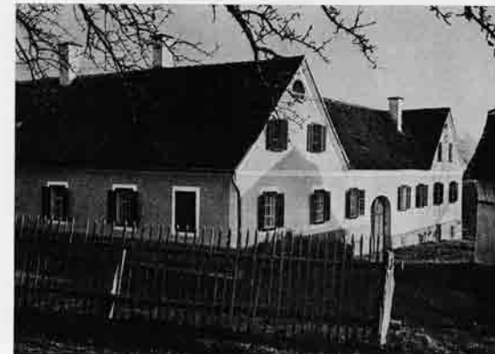
Abb. 36. Oststeirischer Bierfeiler gekennzeichnet durch die zwei aus den Satteldächern hervorstechenden Seitengiebel. (Schildbach bei Hartberg.)
